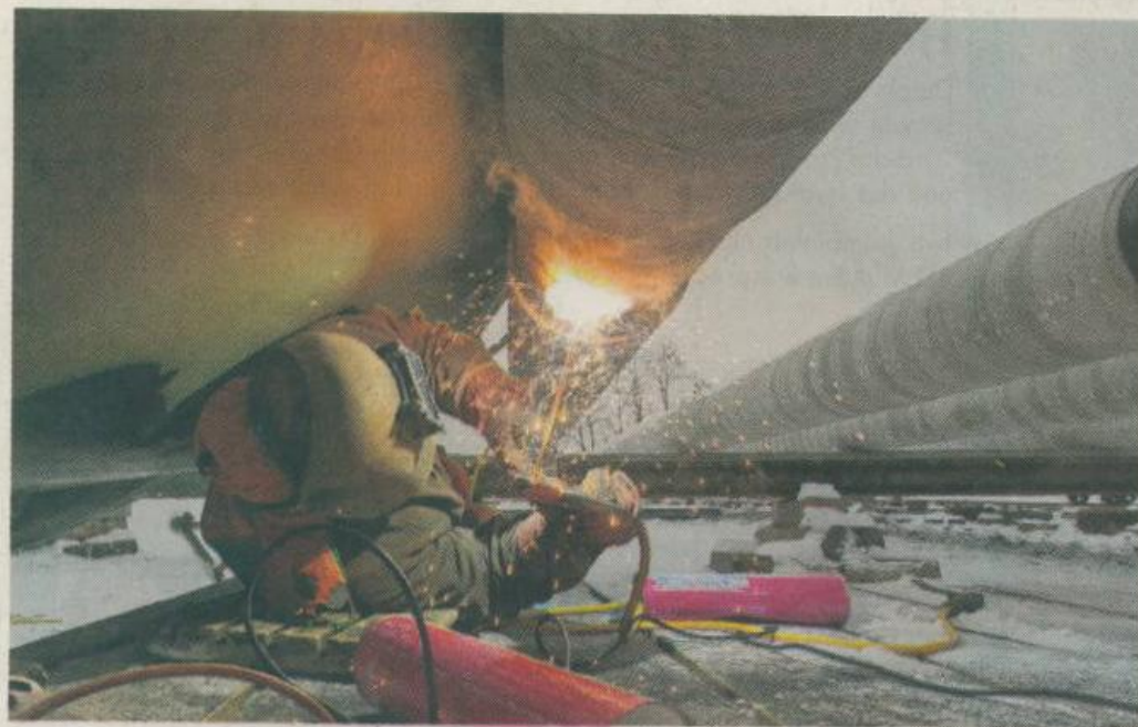
Im Pfäffiker Unterdorf werden die Rohre zusammenschweisst.
